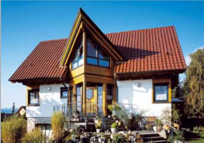
Wykończenie dachówką boczną lewą z deską szczytową*
